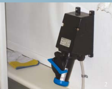
Forskellige eksempler på elektriske komponenter i laboratorier. Billede 1 viser EX-belysning i stinkskab. Billede 2 viser EX-stikkontakt i klassificeret laboratorieområde. Billede 3 viser EX-nødbelysning og lysstofarmatur i kemikalierum.
