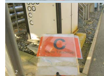
Billede 1 og 2 er eksempler på orange standere til afmærkning af område med varmt arbejde med varm tilladelse.
